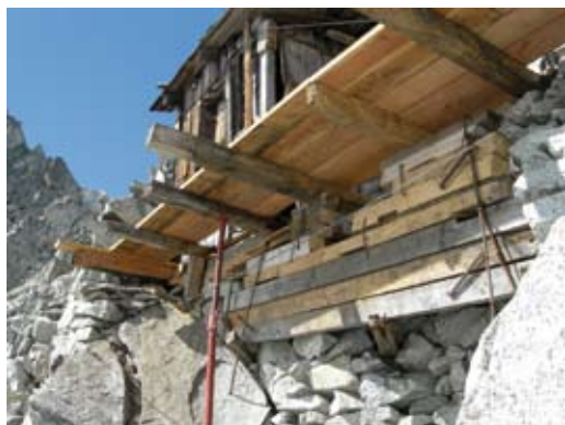
Foto 6 - Lavori alla baracca del Carè Alto
